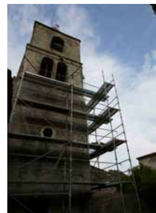
Travaux du clocher
